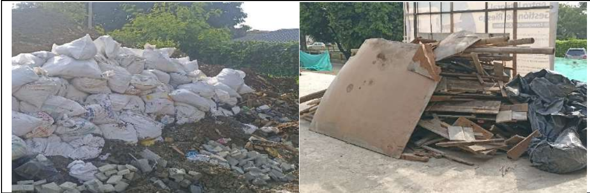
Ilustración 4 Manejo de materiales en obra
