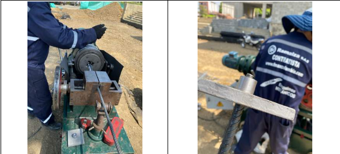
10. Roscado de varillas ½" por parte de la empresa RAMALZA S.A.S.
