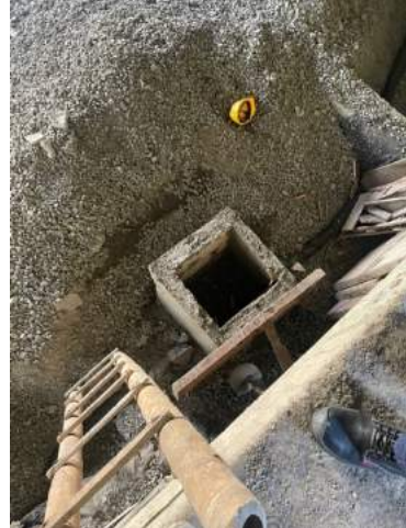
9. Instalacion de redes sanitarias enterreadas, tuberia de drenaje en bodega (Nivel - 4.40) / Armado y fundicion de caja de inspeccion (80X80 cm)
