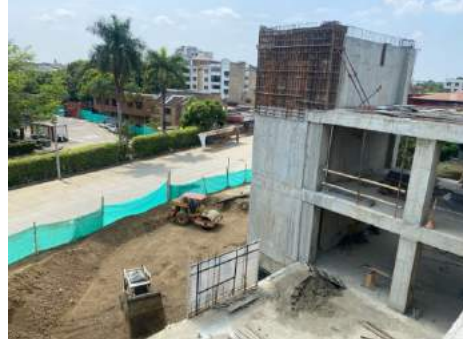
1. Encofrado pantallas punto fijo 3 entre niveles + 10.00 y + 14.20
