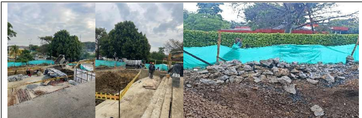
Ilustración 1 Demarcación y señalización de obra
