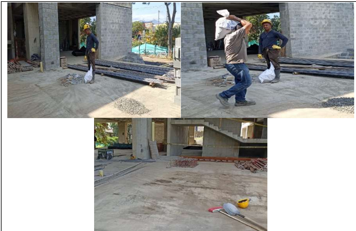
Ilustración 7 Jornada de limpieza de obra
