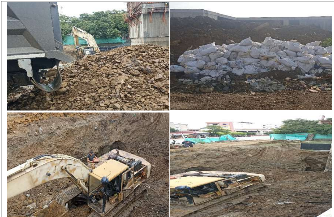
Ilustración 6 Excavaciones y relleno
