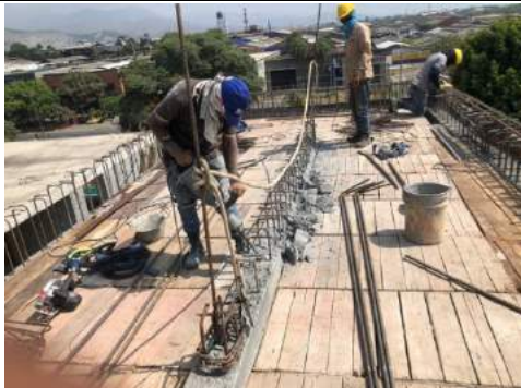
3. Armado de acero vigas y viguetas losa de cubierta del punto fijo 3 nivel + 14.20
