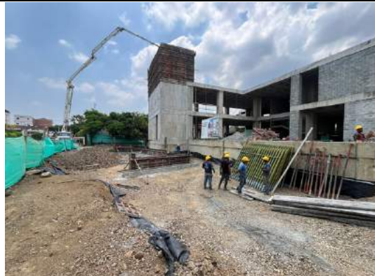
4. Fundición con concreto de 4500 PSI, losa de cubierta del punto fijo 3 nivel + 14.20 y Columna K4
