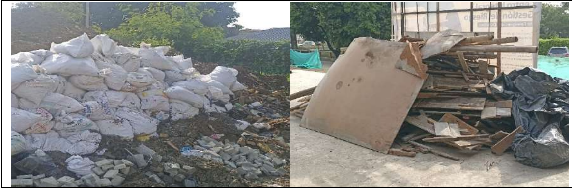
Ilustración 4 Manejo de materiales en obra
