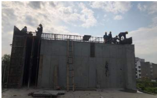
2. Armado de entarimado losa de cubierta del punto fijo 3 nivel + 14.20
