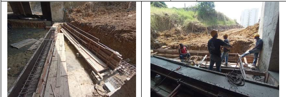
15. Perforaciones y anclaje (45 cm de profundidad) acero vigas de cimentacion / Encofrado de vigas de cimentacion en sotano (Nivel -4.40)
