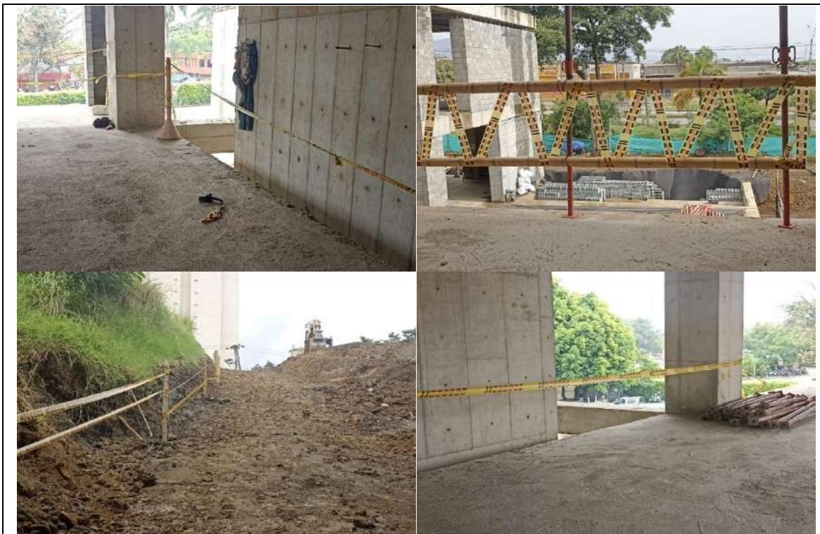
Ilustración 2 Señalización de obra
