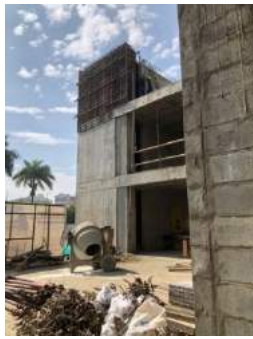
1. Encofrado pantallas punto fijo 3 entre niveles + 10.00 y + 14.20
