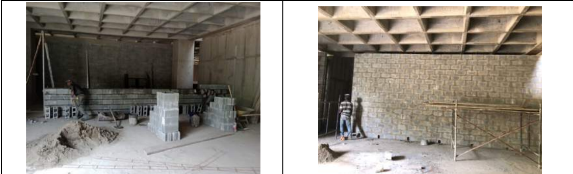
11. Pega de muros con bloque de 14x19x39, zona U.A.R. en semisótano (Nivel – 2.60)
