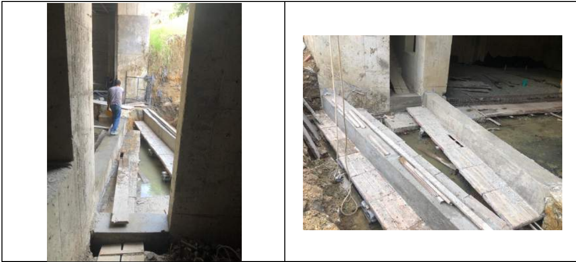
16. Fundición de vigas de cimentación bodega nivel -4.40 m.
