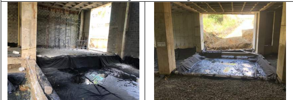
17. Instalación de geotextil T1600 cuadrantes faltantes en sótano (nivel -4.40 m)
