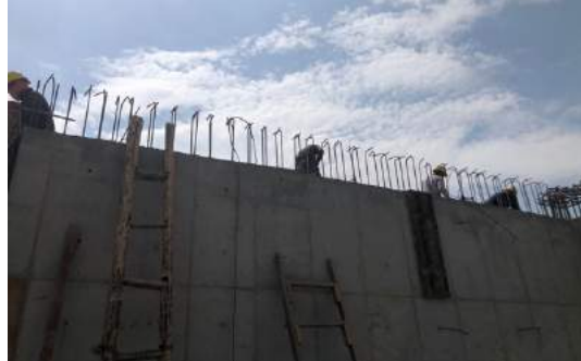
2. Armado de entarimado losa de cubierta del punto fijo 3 nivel + 14.20
