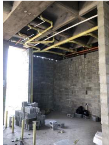
8. Instalacion de redes sanitarias descolgadas losa piso 2 (Nivel +1.60)
