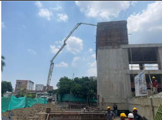
4. Fundición con concreto de 4500 PSI, losa de cubierta del punto fijo 3 nivel + 14.20 y Columna K4
