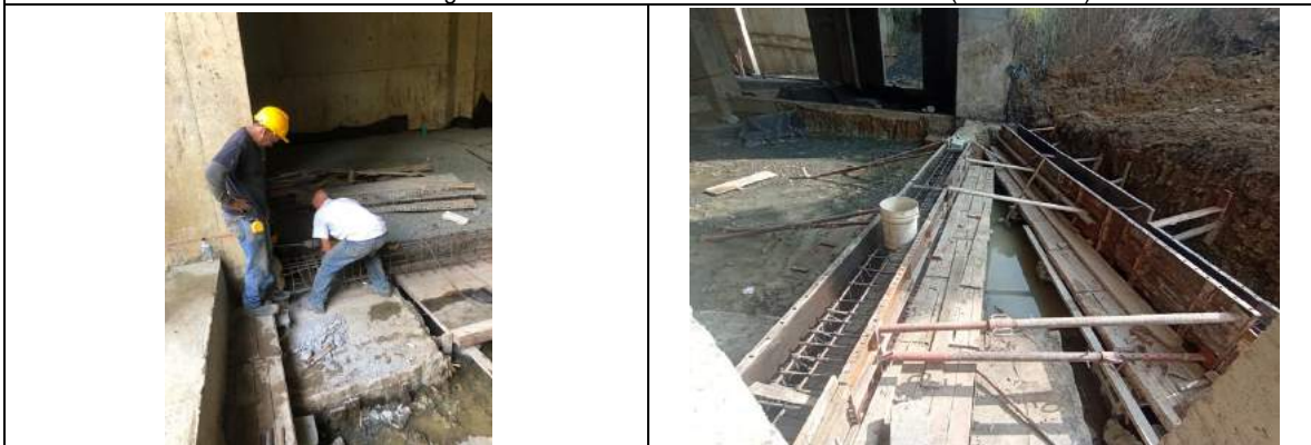
15. Perforaciones y anclaje (45 cm de profundidad) acero vigas de cimentacion / Encofrado de vigas de cimentacion en sotano (Nivel -4.40)
