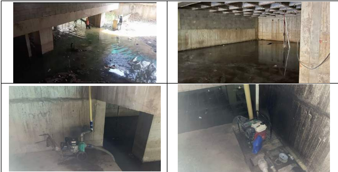
14. Bombeo agua nivel freático con 3 motobombas en sótano (Nivel – 6.05)
